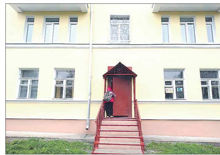
Капремонт подарил дому новую жизнь
