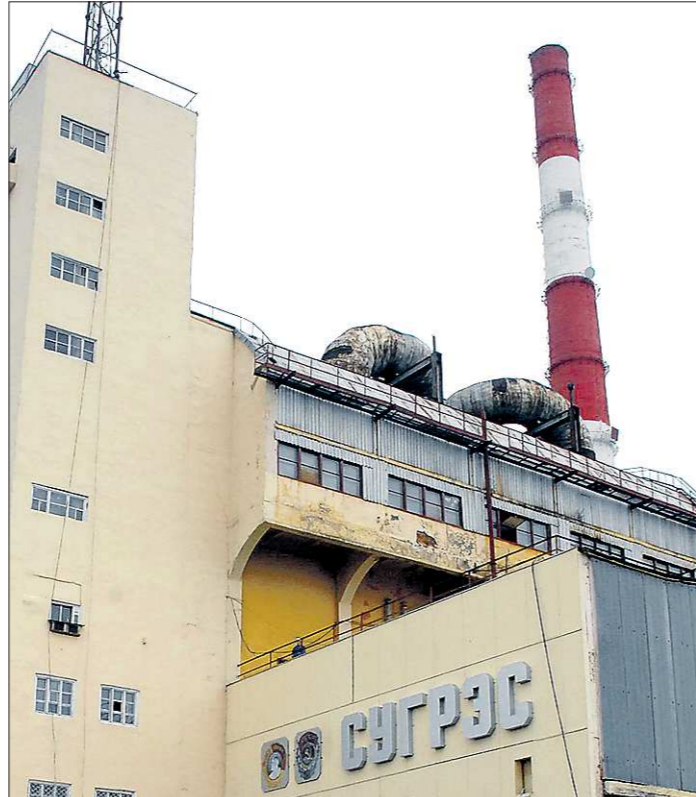
Среднеуральская ГРЭС обеспечивает около 30 процентов тепла и около 40 процентов горячего водоснабжения для Екатеринбурга
