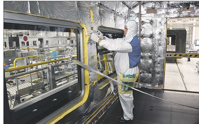
Участок предварительного монтажа – установка системы теплоизоляции внутри вагона
