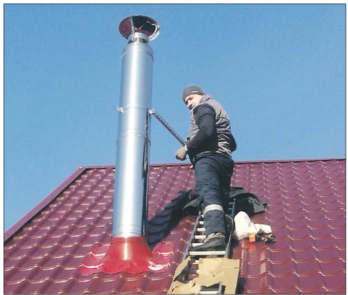
Для автоматического котла необходимо смонтировать дымоход
