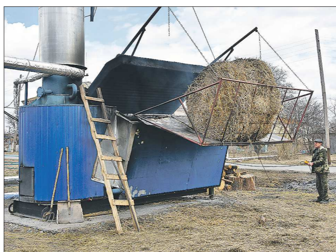
Оператор котельной в селе Чурманском (и наш подписчик) Андрей Шевелёв загружает в котёл очередной тук соломы
