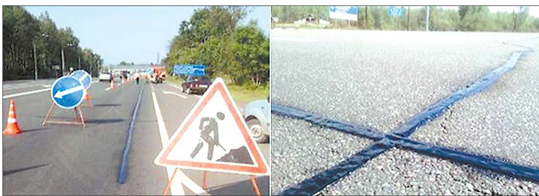
Битумно-полимерная лента, предназначенная для санации трещин асфальтобетонного покрытия
