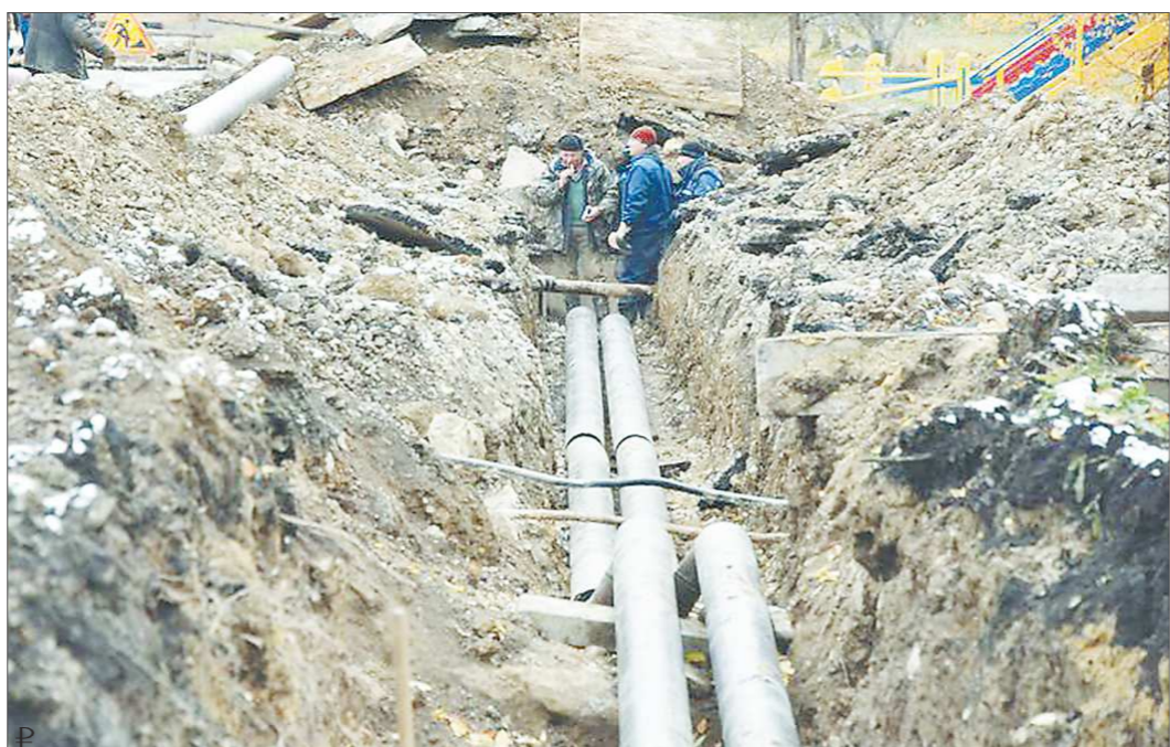
В минувшем году компании «Т Плюс» на Среднем Урале переложили более 72,6 километра трубопроводов
