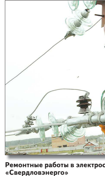
Ремонтные работы в электросетевом комплексе филиала «Свердловэнерго»
