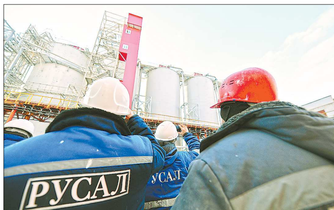
Обновлённый участок декомпозиции представляет собой батарею из шести декомпозиров — аппаратов для разложения алюминиевого раствора
