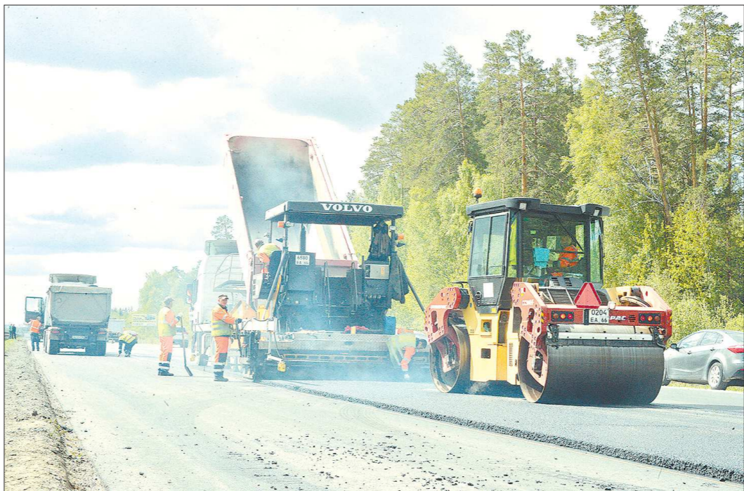
Температура щебёночно-мастичной смеси при укладке составляет почти 150 градусов. От асфальта даже исходит лёгкий дымок
