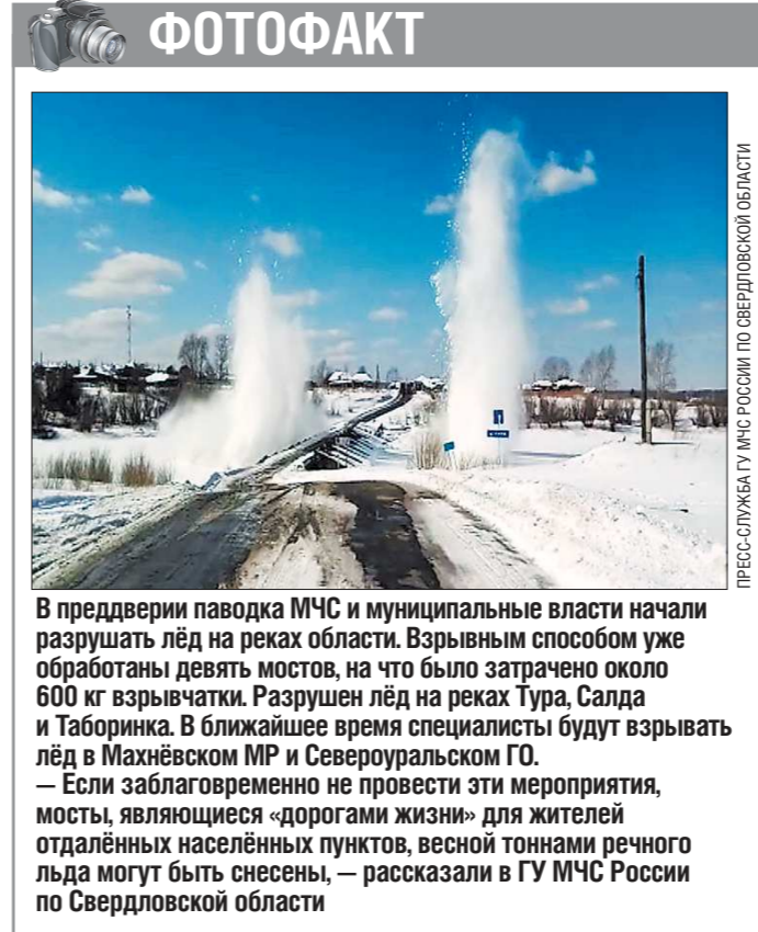
В преддверии паводка МЧС и муниципальные власти начали разрушать лёд на реках области. Взрывным способом уже обработаны девять мостов, на что было затрачено около 600 кг взрывчатки. Разрушен лёд на реках Тура, Салда и Таборинка. В ближайшее время специалисты будут взрывать лёд в Махнёвском МР и Североуральском ГО.
