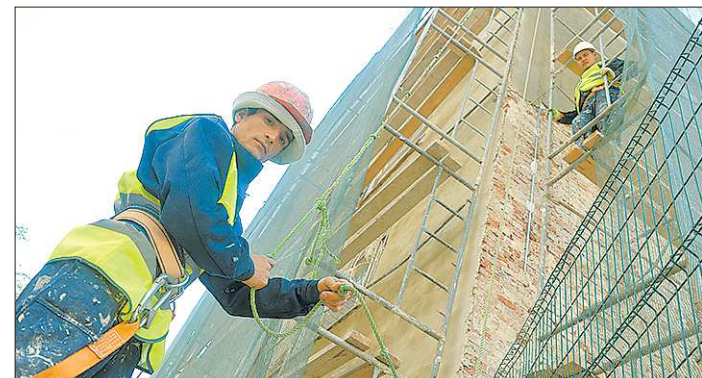
В 2017 году в Свердловской области капитально отремонтировано 2 408 многоквартирных домов
