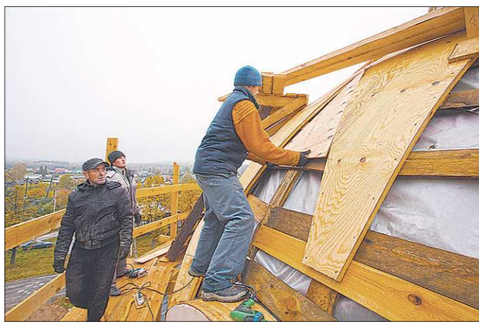
Сейчас на куполе храма идут кровельные работы
