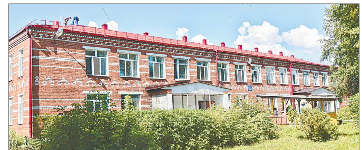
Закончен капитальный ремонт кровли Ачитского детского сада «Тополь»
