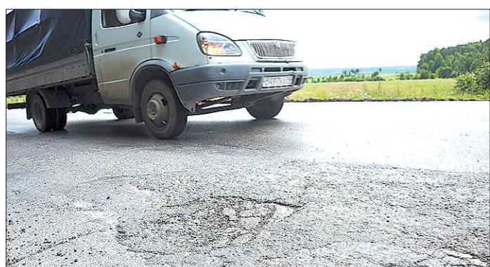
В этом году планировали отремонтировать 3 км выезда с Челябинского тракта в сторону нефтебазы, а придётся — 9 км
