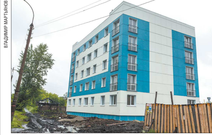
Дом по улице Ленина для переселенцев из ветхого и аварийного жилья сдадут в конце августа. Таким образом, все туринцы, чьи дома были признаны аварийными до 1 января 2012 года, получат новое жильё
