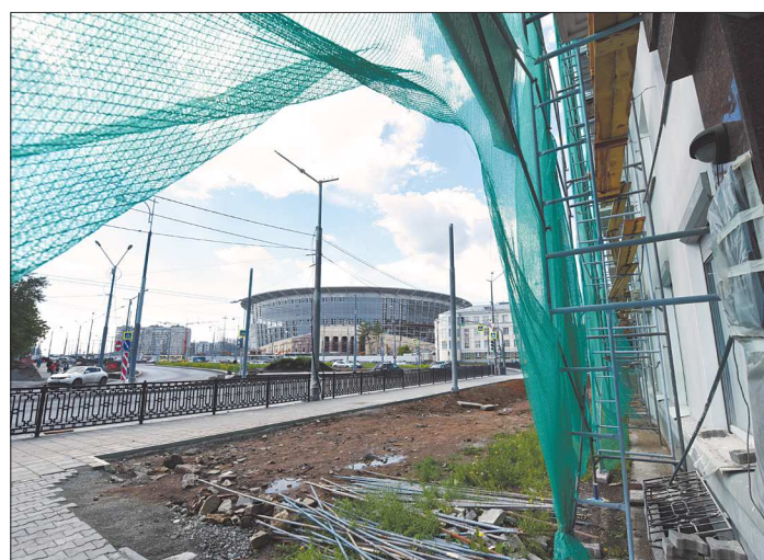
Особое внимание мэрия будет уделять фасадам домов, расположенных неподалёку от стадиона
