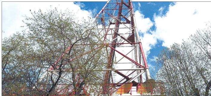
Высота телебашни на Луначарского — 180 метров, плюс 19 метров — шпиль. Внизу видны зелёные тарелки приёма сигнала, а все передающие антенны расположены на самом вершине
