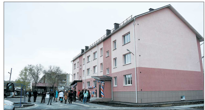
Строительство дома началось еще в 1990 году, но через год из-за сложностей с финансированием работы были приостановлены вплоть до 2015 года
