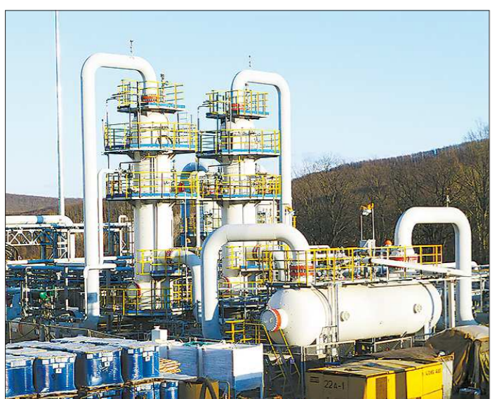
Монтаж оборудования на КС «Краснодарская»
