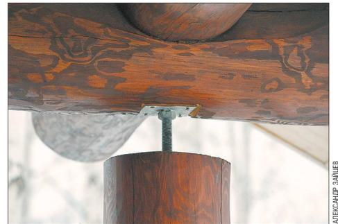
При помощи гайки высота компенсатора меняется
