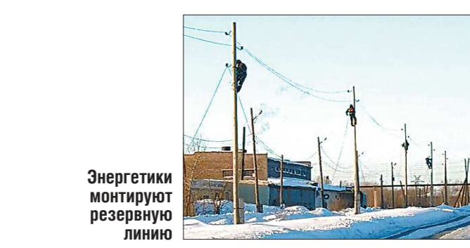
Энергетики монтируют резервную линию
