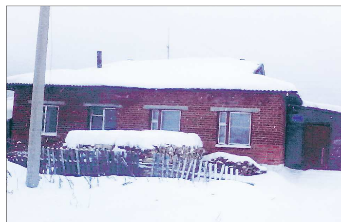
После установки новой системы отопления поленица стала ненужной, а теперь замело и сам ФАП в посёлке Лазоревом
