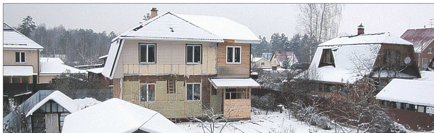
Этот дом как раз находится в стадии утепления – идёт закрепление твёрдой минеральной ваты, следующий этап – чистовая отделка
