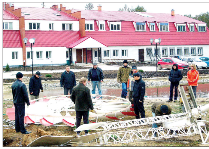
2007 год, идёт сборка и монтаж ветроэлектростанции. С тех пор как учёные занялись энергоэффективным домом, для друзей отпала проблема с выбором подарка — принесёшь им аккумулятор или солнечную панель — они и радёхоньки...
