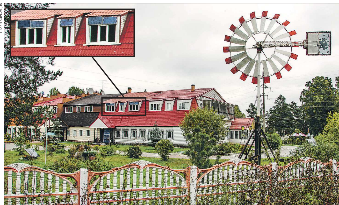
Солнечные панели (выделены на фото), расположенные на окнах двух квартир, на крыше дома и на специальных установках, выдают постоянный ток и заряжают аккумуляторы. Накопленную электроэнергию можно пустить на освещение светодиодными лампами при 12 вольтах либо преобразовать в переменный ток, чтобы можно было включать электроприборы
