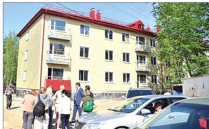
На встречу с жителями свердловский премьер приехал сразу после осмотра строящегося дома для переселенцев из аварийного жилья, по которому у красноуринцев тоже были вопросы. Месяц назад нерадивого подрядчика сменили. У новых строителей остался месяц, чтобы сдать объект
