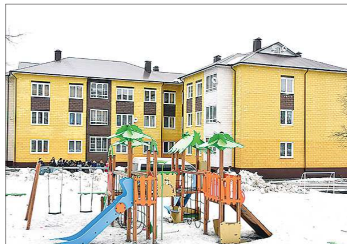
В доме по адресу Куйбышева, 2а переселенцы живут ровно год и не находят, к чему придраться
