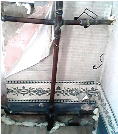
Заменяя трубу в качканарской квартире, ремонтники оборвали обои и продирали пол
