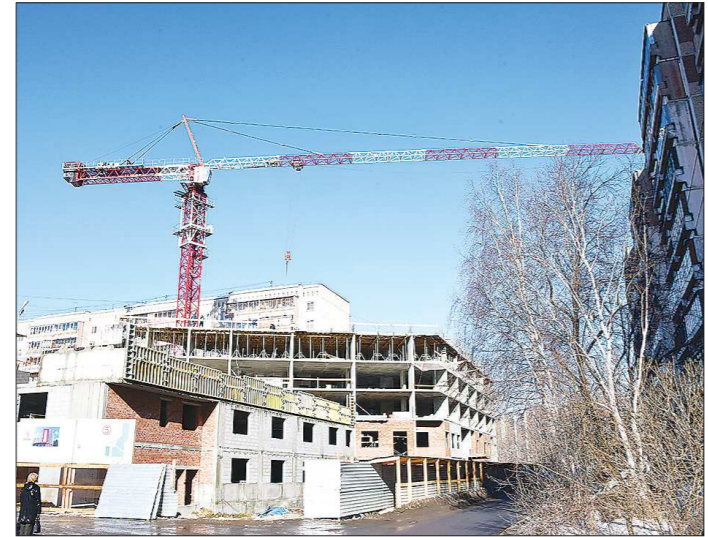
Новые здания в Екатеринбурге возводятся прямо во дворах так, что краны нависают над жилыми домами
