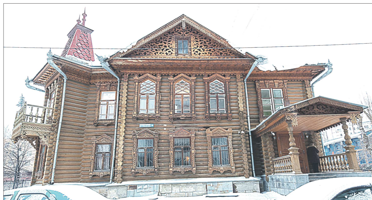
Сам дом – жемчужина деревянного зодчества. Он интересен с точки зрения архитектуры: здесь соединяются элементы восточного декора с давними уральскими народными традициями резьбы по дереву и с приёмами классицизма. Он был построен в 1896–1898 годах, а его архитектор до сих пор не установлен
