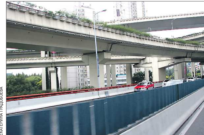
К строительству многоуровневых шоссе и развязок в Шанхае приступили с начала 90-х. Сегодня эта работа в центральной части города сделана, на очереди — городские окраины
