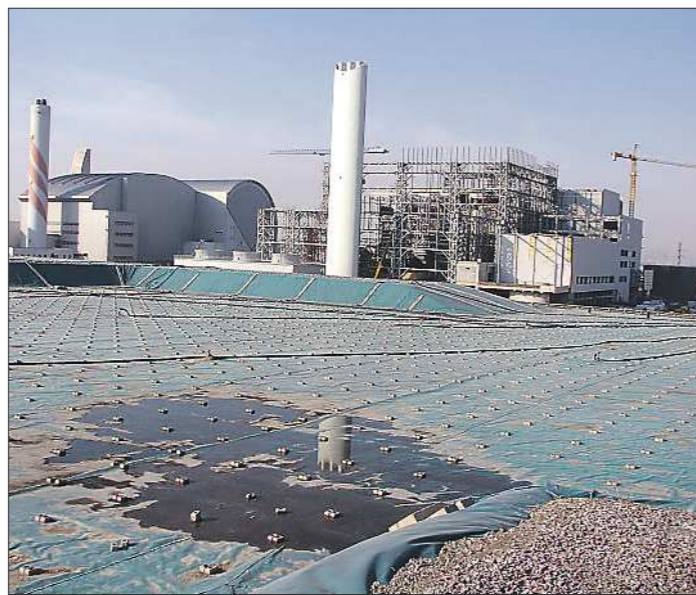
На дальнем плане — два мусоросжигающих завода Промышленного парка района Чаоян (действующий и строящийся), на переднем плане — полигон для захоронения остатков сожжённого мусора
