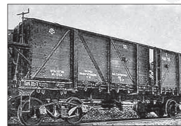
Первенце Уралвагонзавода — четырёхосный полувагон грузоподъёмностью 60 тонн с деревянной обшивкой кузова
