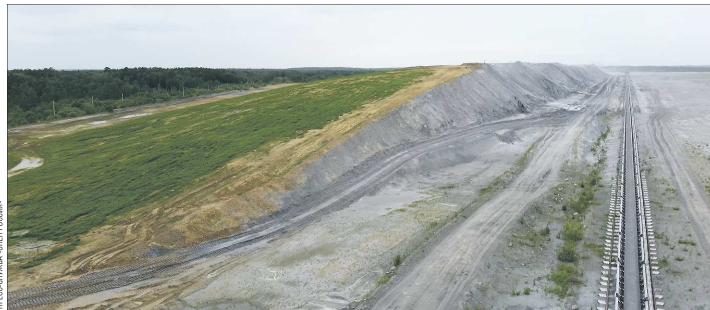
Часть золоотвала Рефтинской ГРЭС засеяна травой
