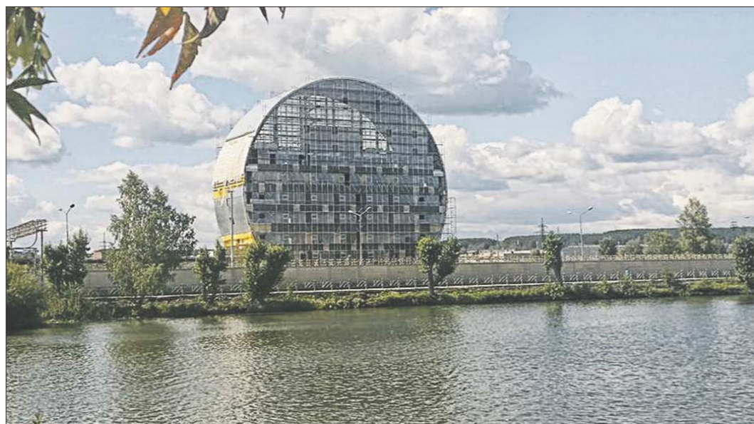
Строительство ИКЦ проходит на территории Старотрубного завода Первоуральска. Необычное круглое здание, которое горожане прозвали «шайбой», возвели по проекту архитектурного бюро Begnaskoni
