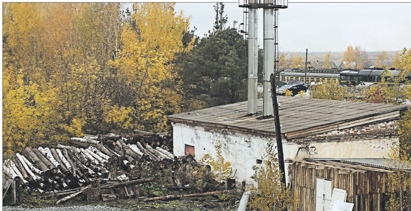
С помощью государственных субсидий удастся реконструировать морально устаревшие теплопункты и сети
