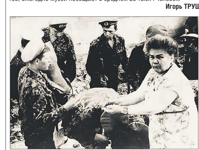
Н.И. Михайлова на строительстве здания музея
