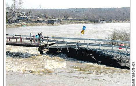
В посёлке Шамары Шалинского ГО обрушился резервный мост через Сыльву, построенный на время ремонта основного моста. Сильный паводок размыв насыпь.
