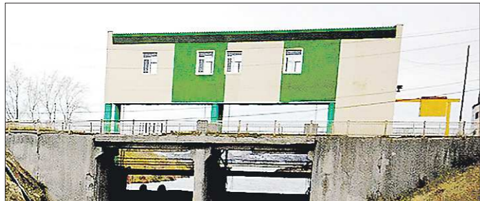
На обновление плотины в Верхней Салде понадобилось более тысячи кубометров бетона
