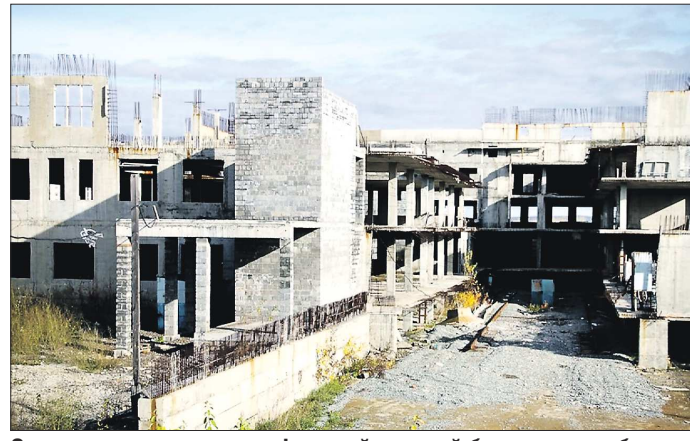
Строительство многопрофильной детской больницы, на базе которой в будущем хотят сосредоточить всю тагильскую педиатрию, началось ещё в 1995 году и за 20 лет практически не продвинулось
