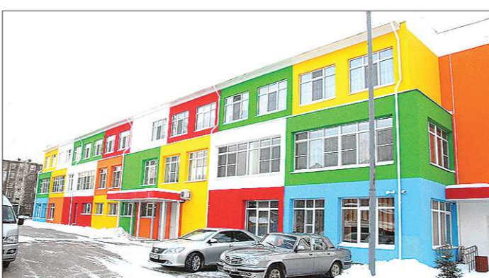
Сложно поверить, но этот детский сад в Среднеуральске — 1969 года постройки. В 2013 году его реконструировали и надстроили третий этаж, увеличив вместимость со 115 до 240 детей
