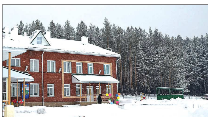
Садик «Улыбка» в Сысерти на 135 мест сдали в апреле прошлого года. Сейчас в округе строят ещё пять детсадов
