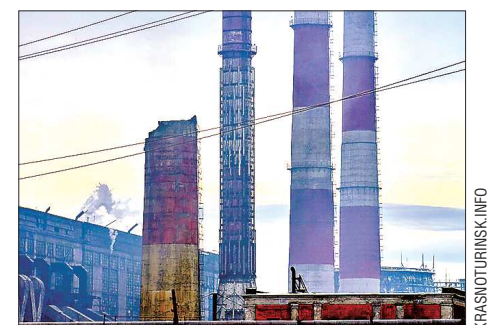
Обрушение трубы не повлияло на работу Богословской ТЭЦ
