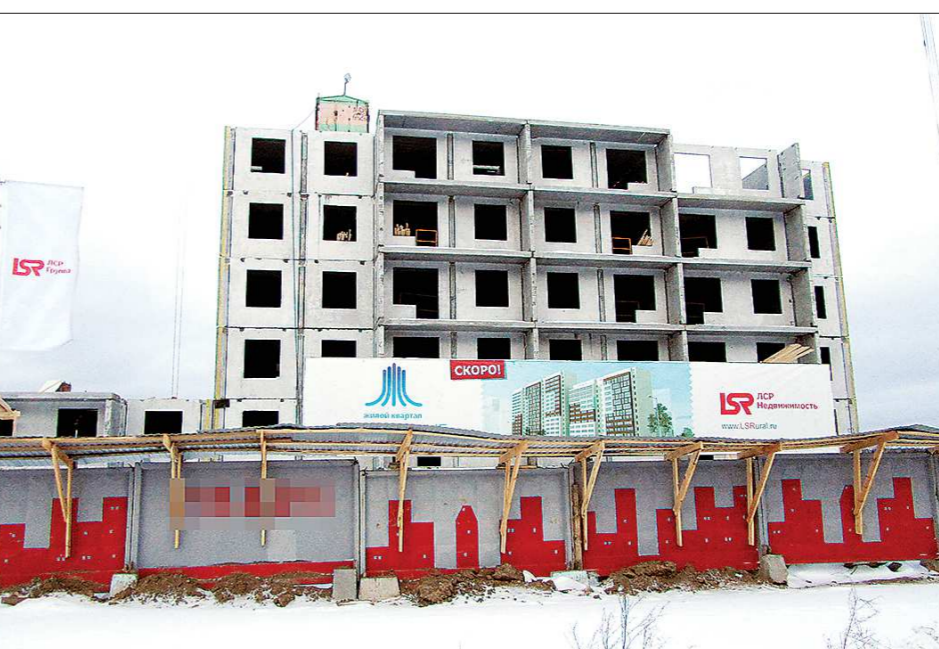
Дома возводятся из сборных железобетонных панелей. Фасады будут облицовываться теплоизоляционным материалом. Эта технология, не очень популярная в Свердловской области, хорошо зарекомендовала себя в Санкт-Петербурге
