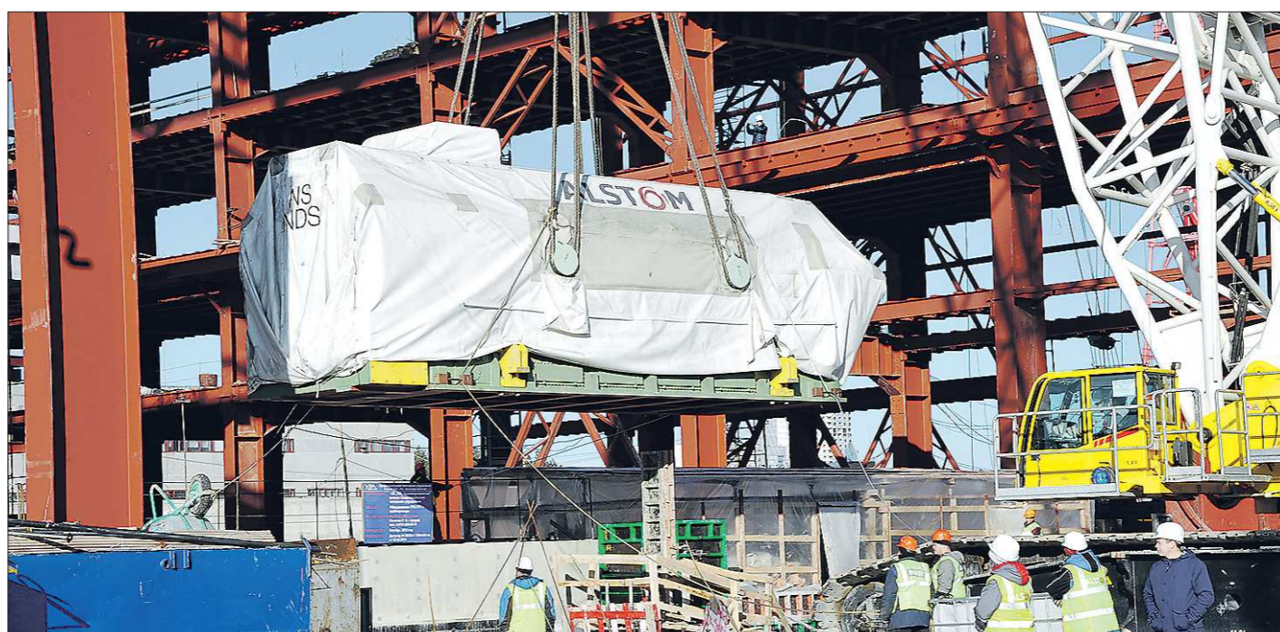
Через пару минут груз весом в 250 тонн будет установлен точно на специальный фундамент
