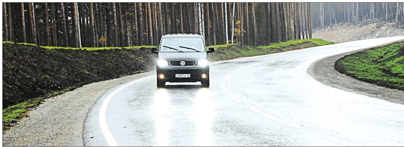
260 тонн взрывчатки потребовалось для прокладки этой автотрассы
