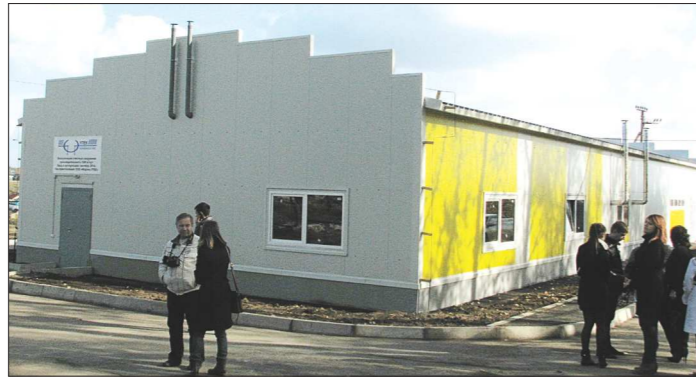
Это очистное сооружение возвели рядом с местным ДК. Санитарная зона всего 15 метров. На входе туда попадают канализационные стоки, а на выходе вода получается чище, чем в реке
