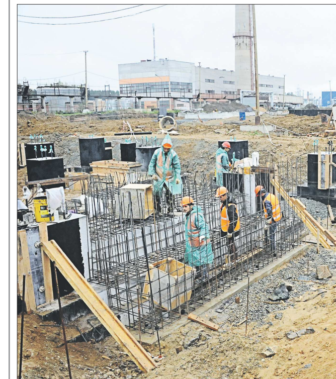
К концу нынешнего года будет сдана первая очередь паргазовой ТЭЦ «Академическая», полное завершение строительства которой запланировано на 2016 год. Вчера стройплощадку осмотрели председатель правительства Свердловской области Денис Паслер и гендиректор ЗАО «Комплексные энергетические системы» Борис Вайнзихер. Они отметили, что работы идут по графику. Реализация этого инвестиционного проекта общей стоимостью более десяти миллиардов рублей, ведущаяся на средства ОАО «ТЭК-9», позволит ускорить развитие юго-западной части Екатеринбурга
