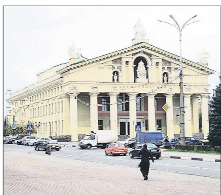
Во время ремонта здания труппа Театра драмы будет выступать на других площадках Нижнего Тагила
