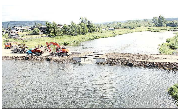
Новый мост в Шамарах строится не скоро, но тяжёлый транспорт уже может спокойно переправу
